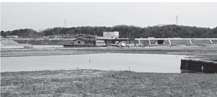
舟橋地内の津幡バイパス沿いで建設が進む(仮称)北部公園
